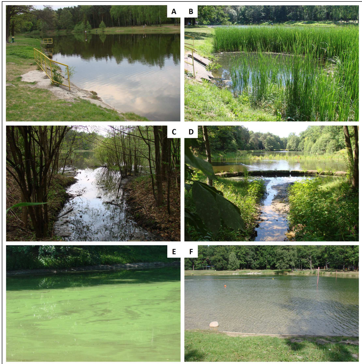
Rys. 4. Miejsce dopływu wód deszczowych do zbiornika Arturówek dolny przed działaniami inwestycyjnymi (A) i po konstrukcji systemu hybrydowego (B). Dopływ rzeki Bzury do zbiornika Arturówek górny przed działaniami inwestycyjnymi (C) i po konstrukcji SSSB (D). Wpływ działań rekultywacyjnych i ochronnych na stan jakości wód w Arturówku (E i F) (fot. T. Jurczak).
